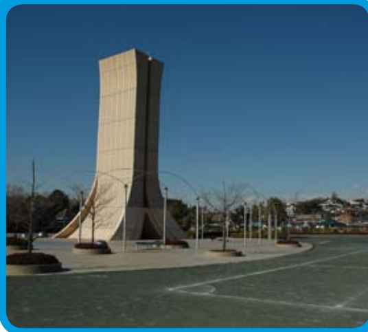
麻生水処理センターの排気塔とふれあいの丘
