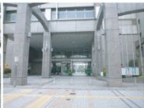
川崎市役所 第三庁舎
