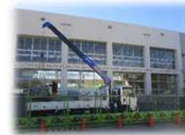
体育館改修工事 完成が楽しみです
