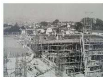
建設中の長尾小
